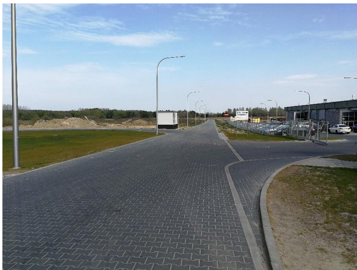
Zdjęcie: Droga wewnętrzna wraz z infrastrukturą techniczną. (źródło: BPI „Invest-Park” SP. z o.o.)
