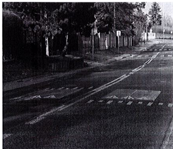
Fotografia 1 i 2. Przykłady zastosowania wyspowego progu zwalniającego (źródło fotografii od lewej: drogipubliczne.eu, kmkrow.pl)
