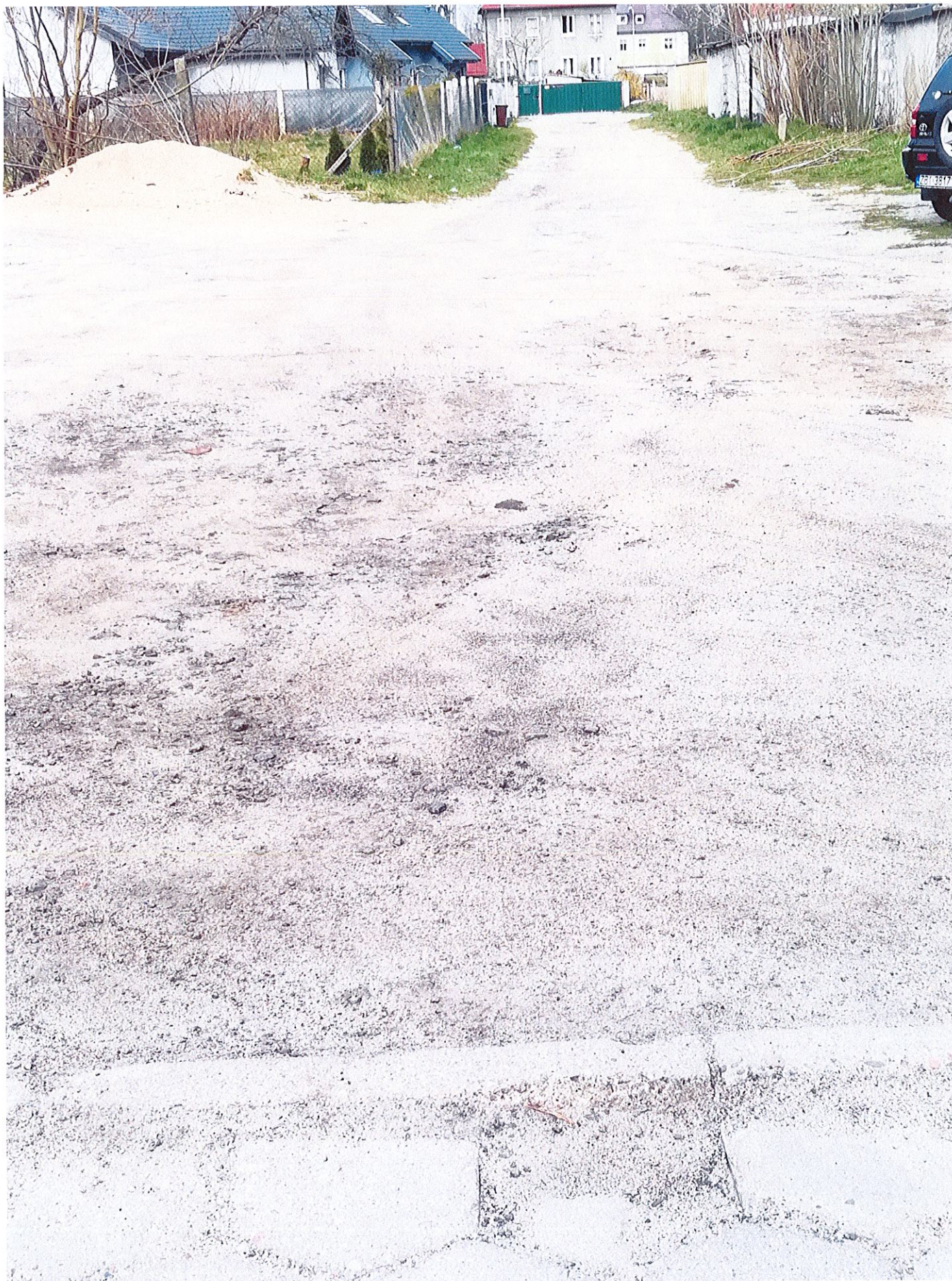
Droga łącząca ul. Piastów z ul. Chopina
