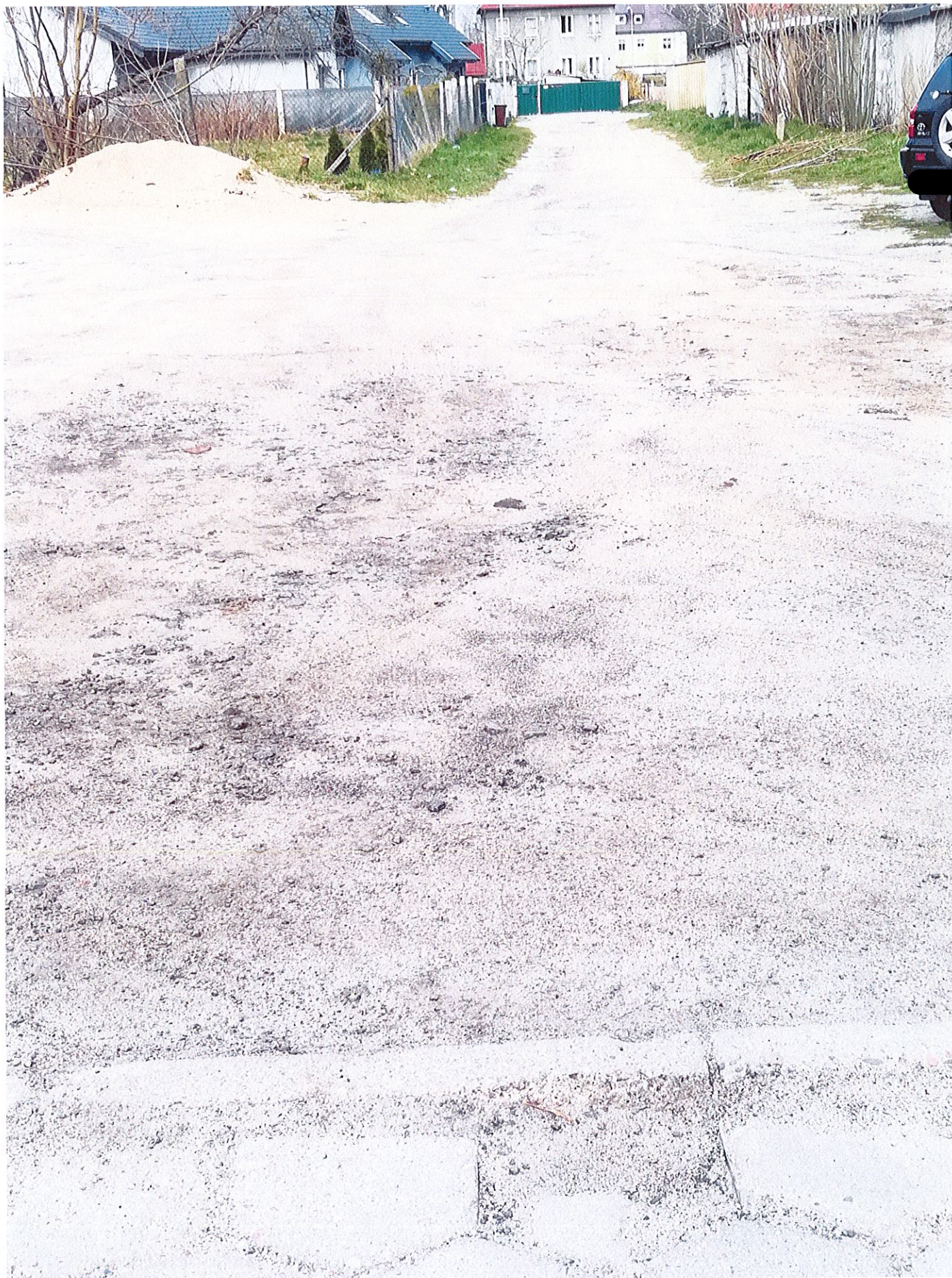
Droga łącząca ul. Piastów z ul. Chopina
