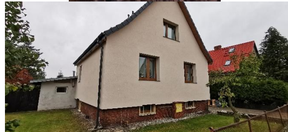
Zdjęcia: Nieruchomość po zakończeniu inwestycji termomodernizacyjnej (źródło: Wydział Gospodarki Nieruchomościami Urzędu Miasta Białogard)
