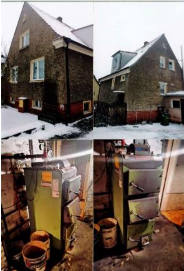
Zdjęcia: Nieruchomość przed inwestycją termomodernizacyjną (źródło: Wydział Gospodarki Nieruchomościami Urzędu Miasta Białogard)
