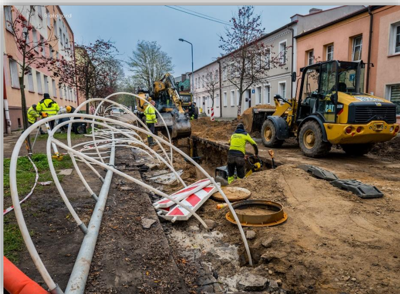
Zdjęcie: Ulica Grunwaldzka w trakcie robót budowlanych (źródło: www.bialogard.info )
